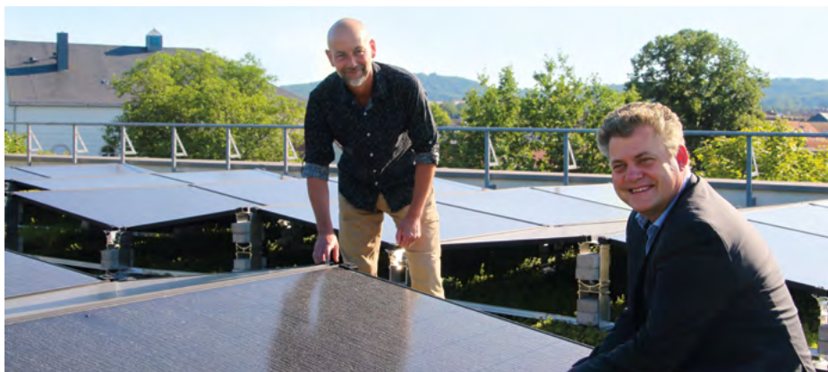
v. r.: Oberbürgermeister Thomas Schubert und Klimaschutzbeauftragter der Stadt Coswig, Jürgen Wellerdt, sehen sich den Baufortschritt der neuen Photovoltaik-Anlage auf dem Rathausdach an
