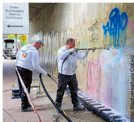
Graffiti-Entfernung an der Eisenbahnbrücke Dresdner Straße
