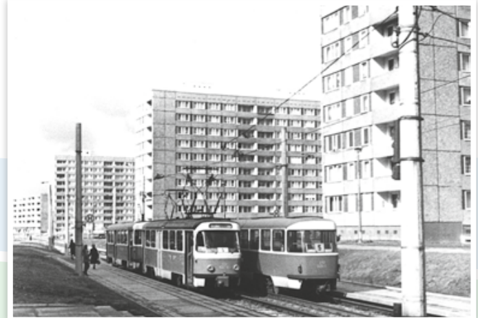
Straßenbahnhaltestelle im Neubaugebiet Dresdner Straße, März 1984
