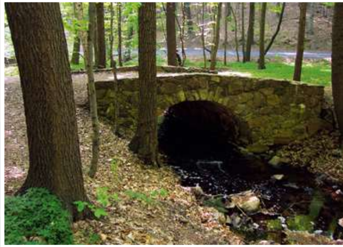
Brücke im Friedewald
